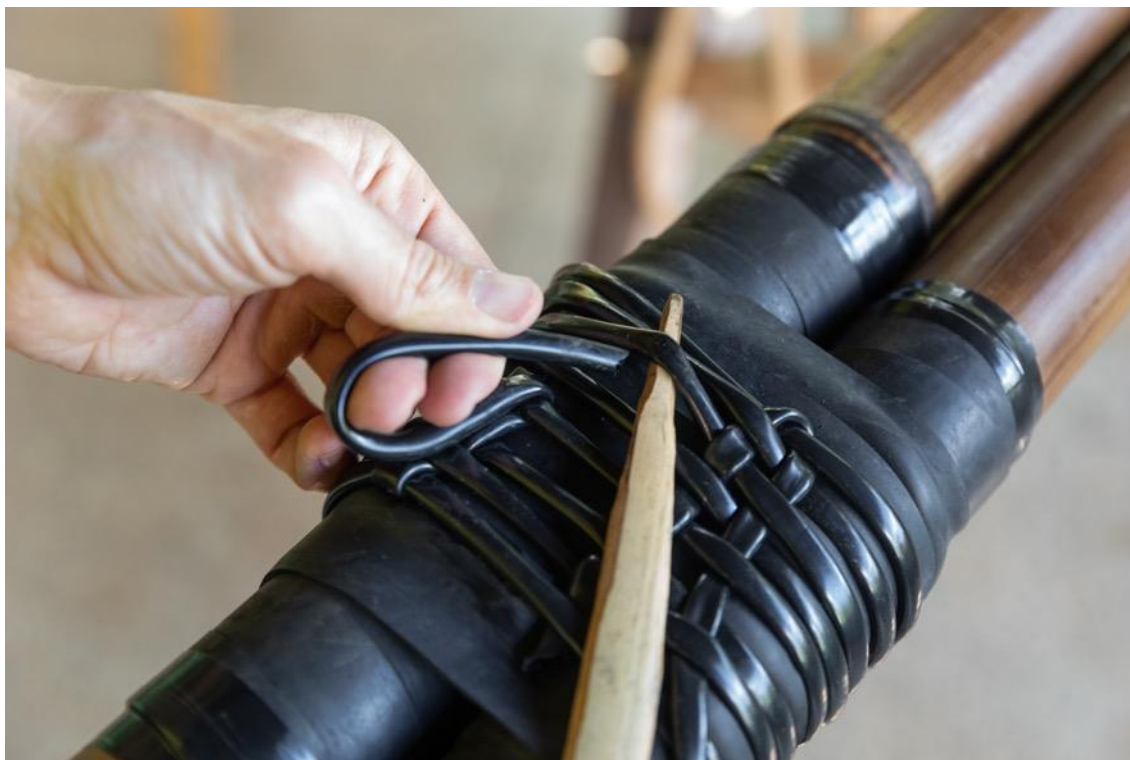
Detalhe de acabamento da amarra do Tripé de Bambu. Foto Janine Moraes.
