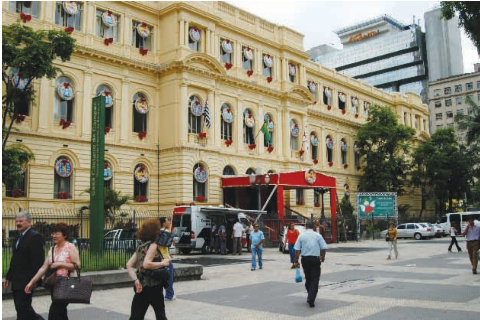
Fachada do prédio da Secretaria de Estado da Educação de São Paulo, na Praça da República, no centro de São Paulo
