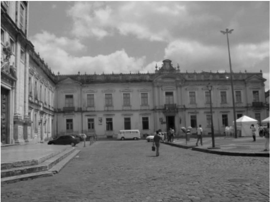
Prédio da antiga Faculdade de Medicina da Bahia
